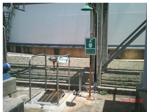
รูปที่ 3.1-1 (รูปที่ 51 อุปกรณ์ชำระล้างฉุกเฉิน)
