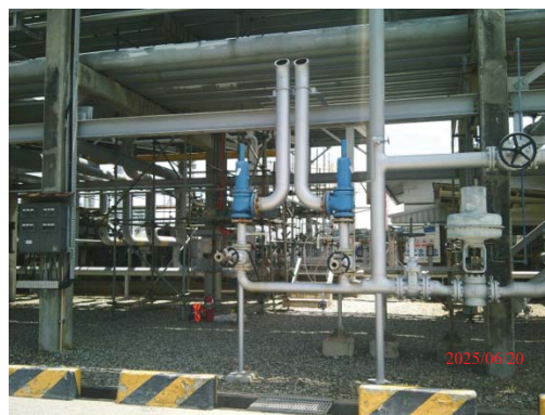
รูปที่ 3.1-1 (รูปที่ 86 Safety Valve บนท่อขนส่ง)
