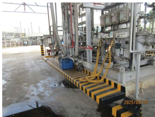
รูปที่ 3.1-1 (รูปที่ 68 Grounding บริเวณ Loading Rack)
