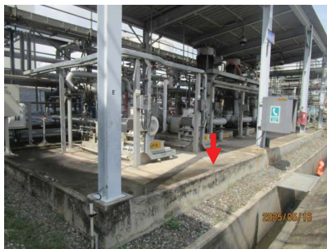
รูปที่ 3.1-1 (รูปที่ 36 คั่นคอนกรีตบริเวณปั๊มที่อยู่ในพื้นที่ที่มีหลังคา)
