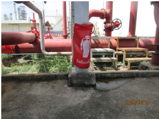
รูปที่ 3.1-1 (รูปที่ 74 เครื่องดับเพลิงชนิดผงเคมีแห้ง)
