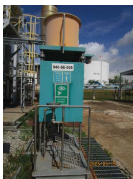
รูปที่ 3.1-1 (รูปที่ 53 Eye Washer บริเวณ UF&RO)
