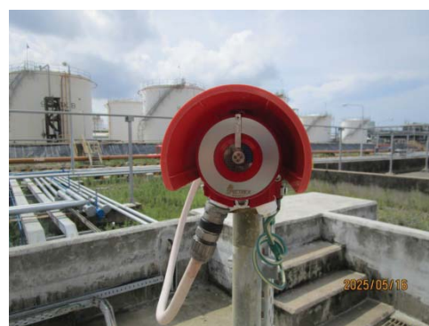
รูปที่ 3.1-1 (รูปที่ 64 Flame Detector)
