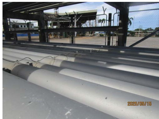
รูปที่ 3.1-1 (รูปที่ 85 สายดินบริเวณท่อขนส่ง)
