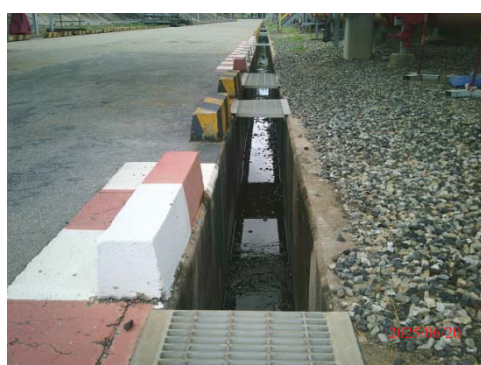
รูปที่ 3.1-1 (รูปที่ 33 Clean Water Sewer (CWS) บริเวณพื้นที่ลานถังเก็บกัก)
