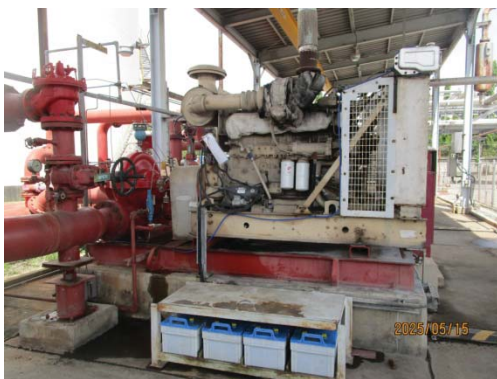
รูปที่ 3.1-1 (รูปที่ 76 ปั๊มน้ำดับเพลิง แบบ Diesel Pump)
