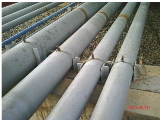
รูปที่ 3.1-1 (รูปที่ 85 สายดินบริเวณท่อขนส่ง)
