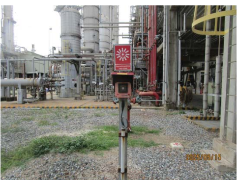
รูปที่ 3.1-1 (รูปที่ 63 Manual Call Point)
