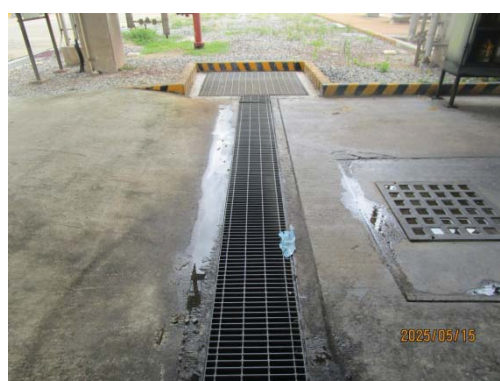
รูปที่ 3.1-1 (รูปที่ 10 Oily Water Sewer)
