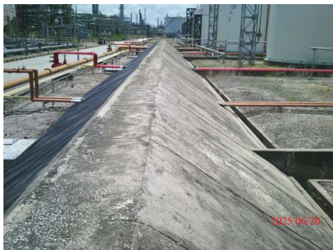
รูปที่ 3.1-1 (รูปที่ 59 คั่นกันล้อมรอบ ถังเก็บสำรอง)
