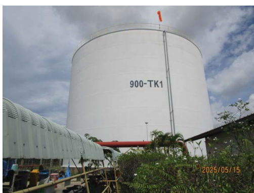
รูปที่ 3.1-1 (รูปที่ 72 ถังเก็บน้ำดับเพลิง)
