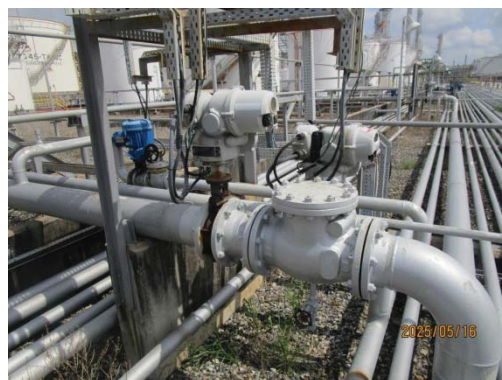
รูปที่ 3.1-1 (รูปที่ 87 Remote Shut-off Valve)
