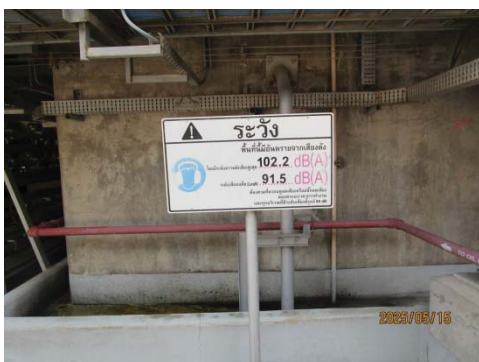
รูปที่ 3.1-1 (รูปที่ 57 ป้ายเตือนบริเวณที่มีเสียงดังเกิน 85 dB(A))
