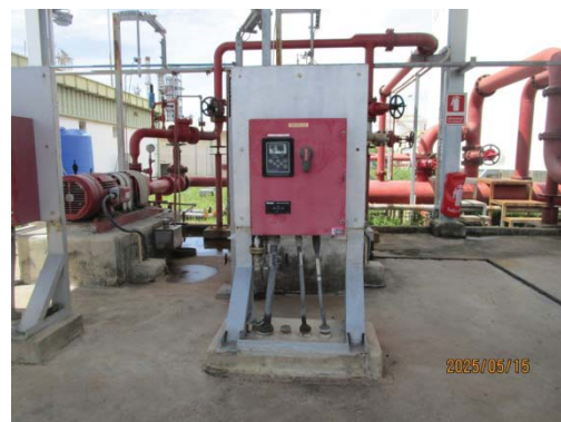
รูปที่ 3.1-1 (รูปที่ 77 Jockey Pump)
