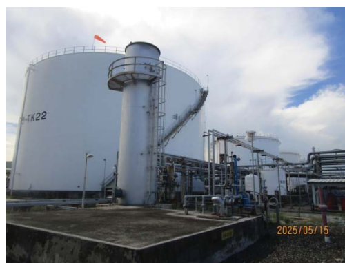
รูปที่ 3.1-1 (รูปที่ 6 ระบบกำจัดไอสาร ไฮโดรคาร์บอน (Vapor Disposal System) บริเวณลานถังเก็บกัก)
