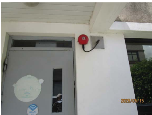
รูปที่ 3.1-1 (รูปที่ 80 กระดิ่งสัญญาณเตือนภัย)
