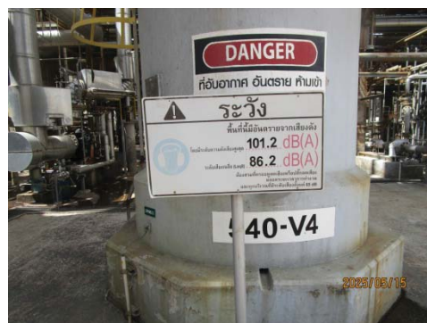
รูปที่ 3.1-1 (รูปที่ 57 ป้ายเตือนบริเวณที่มีเสียงดังเกิน 85 dB(A))
