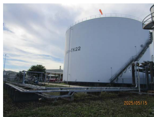
รูปที่ 3.1-1 (รูปที่ 72 ถังเก็บน้ำดับเพลิง)
