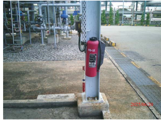
รูปที่ 3.1-1 (รูปที่ 74 เครื่องดับเพลิงชนิดผงเคมีแห้ง)
