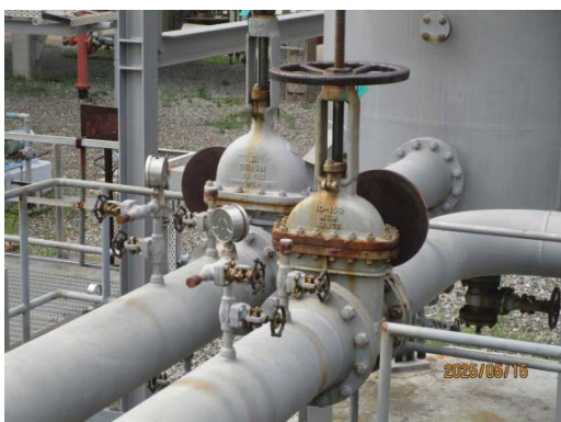
รูปที่ 3.1-1 (รูปที่ 91 วาล์วตัดแยกระบบ)
