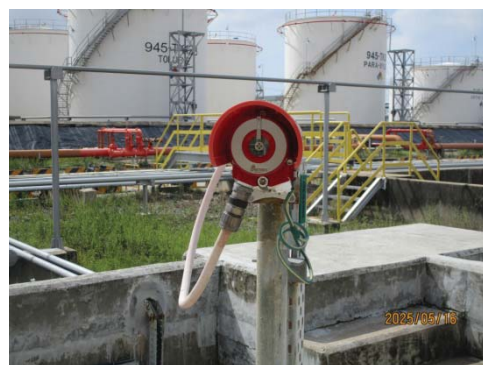
รูปที่ 3.1-1 (รูปที่ 62 Gas Detector บริเวณถังเก็บสำรอง)
