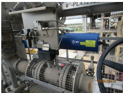
รูปที่ 3.1-1 (รูปที่ 87 Remote Shut-off Valve)
