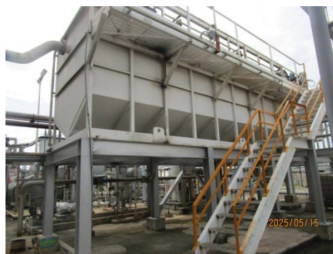
รูปที่ 3.1-1 (รูปที่ 22 Dissolved Air Flootation (DAF))
